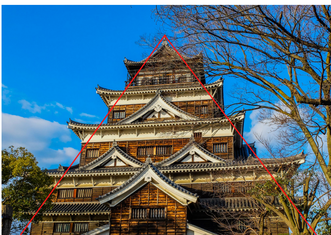
見上げるような大きな建築物も良い
